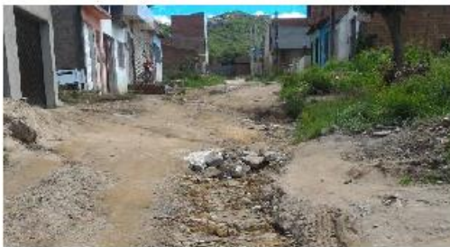
Rua Ana da Conceição, localizada no Loteamento Serranópolis, nesta cidade.
