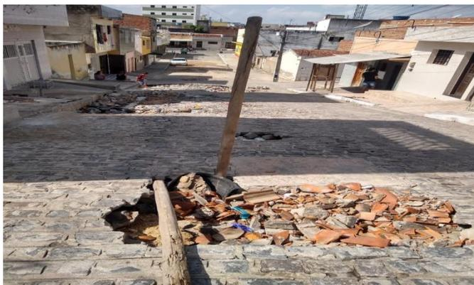
A pavimentação necessita **URGENTEMENTE** de reparação, pois está totalmente danificada pelos enormes buracos na via, devido as fortes chuvas.
