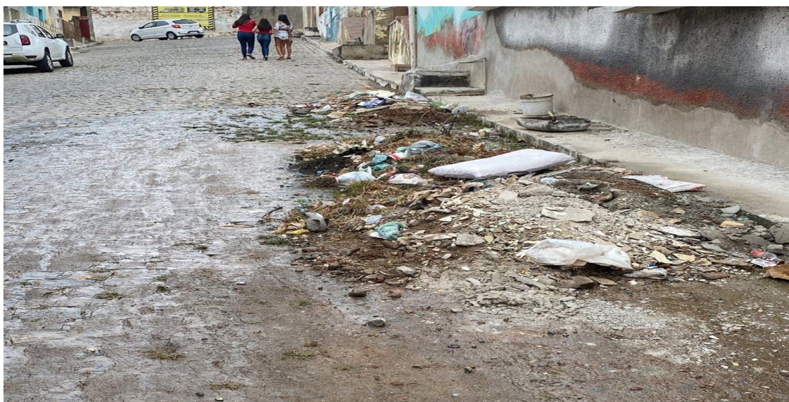
Rua Inácio Sebastião Chaves: retirada de metralhas e entulhos.
