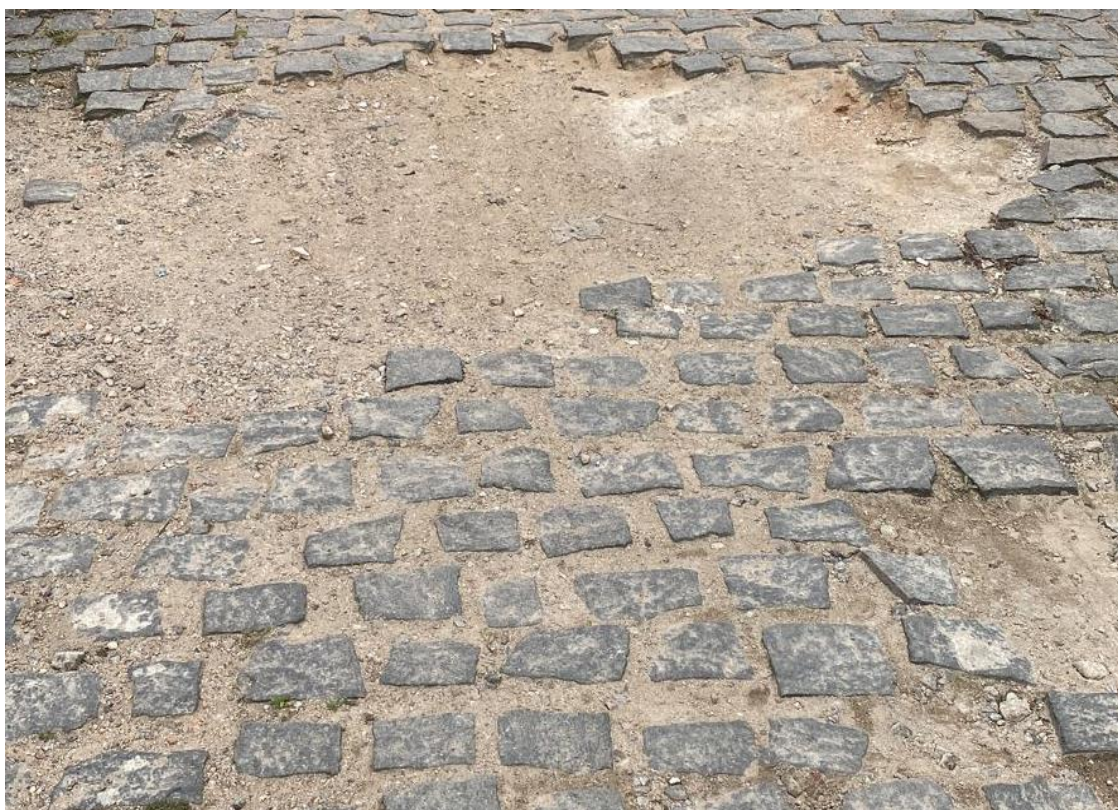
Rua do Corcovado: Retirada de metralhas e manutenção de calçamento
