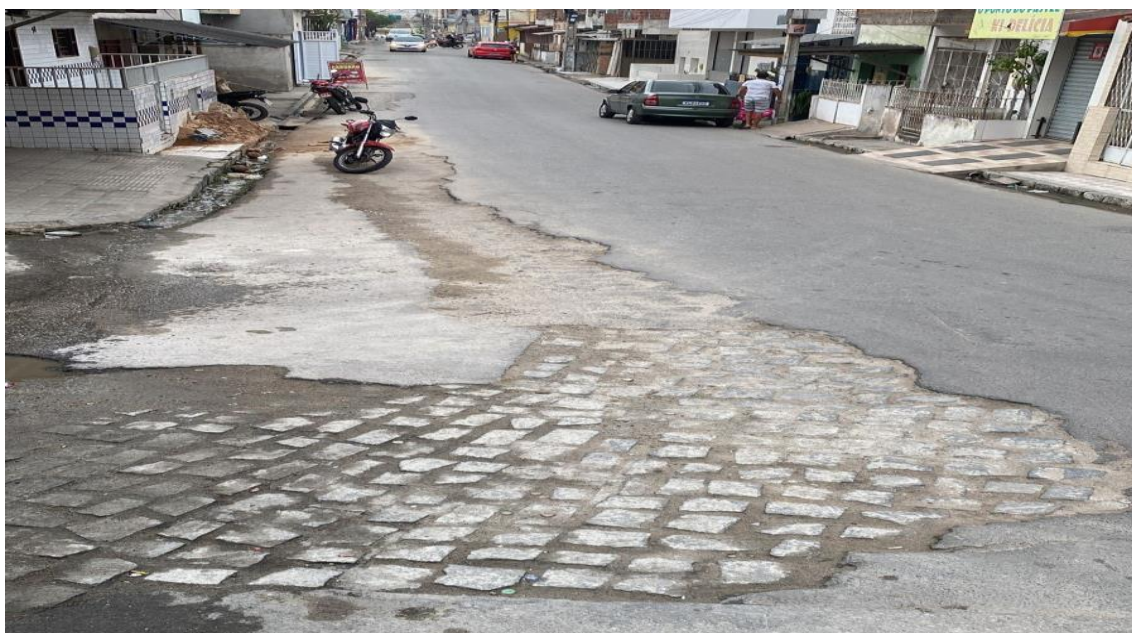
Avenida João Salvador: Manutenção de calçamento e pintura do meio fio
