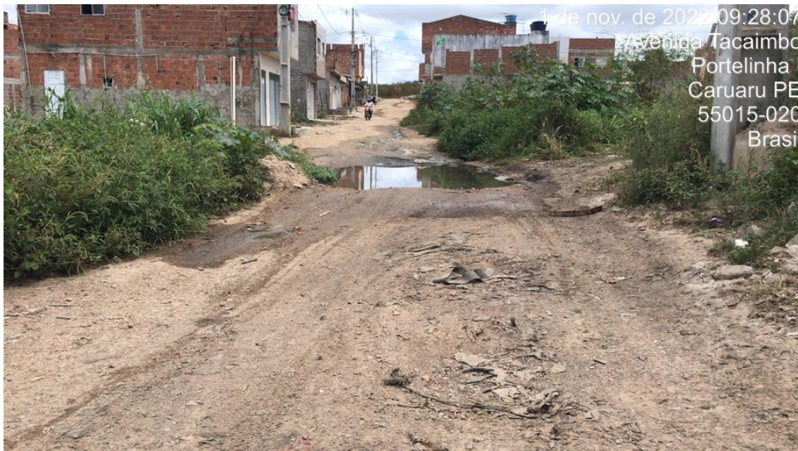
Avenida Tacaimbó: Patrolagem e implantação de uma lixeira na entrada da avenida (ao lado da BR).
