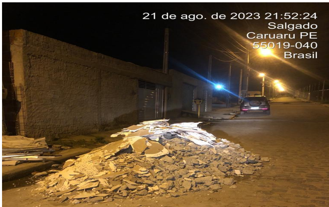
Rua Mário Laurentino (Retirada de metralha)
