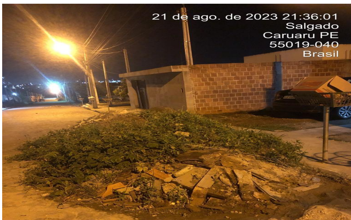
Rua do GD espetus (retirada de metralhas)
