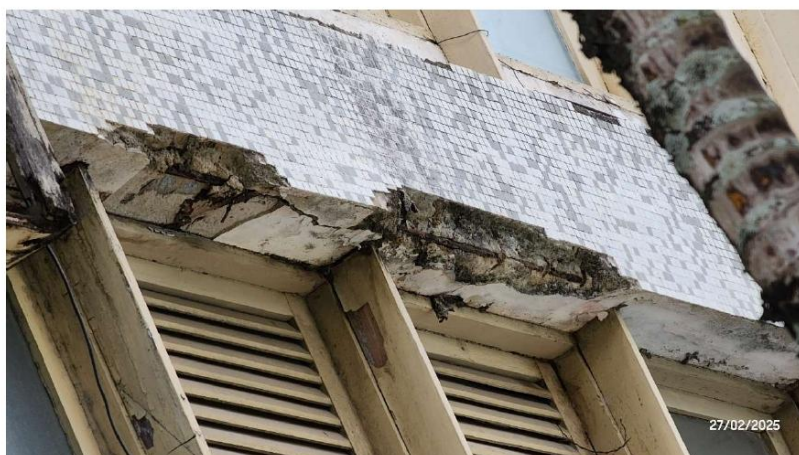
Foto 01: Viga de bordo da fachada muito deteriorada.
