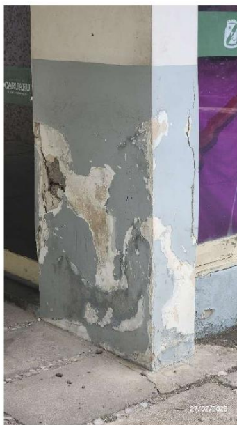
Foto 02: Trecho de pilar no térreo apresentando deslocamento e corrosão de armadura.
