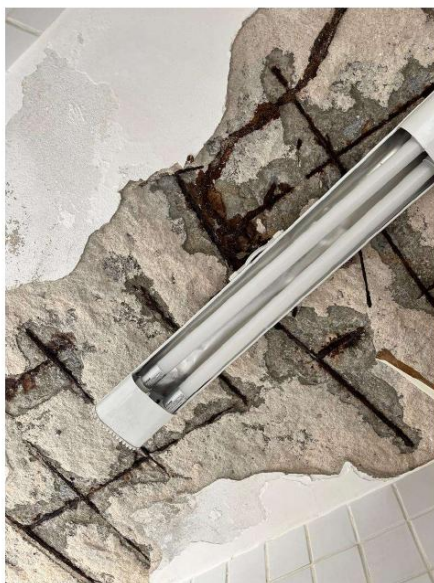
Foto 04: Laje interna do edifício em estado avançado de corrosão de armadura.
