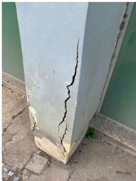
Foto 07: Trecho de pilar no térreo prestes a deslocar devido à corrosão.
