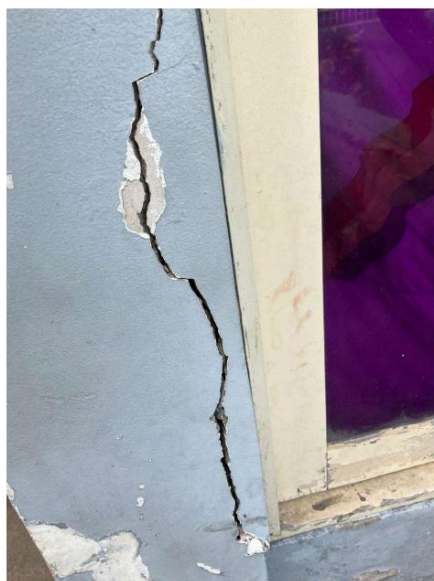
Foto 08: Trecho de pilar no térreo com fortes indícios de corrosão/deslocamento.
