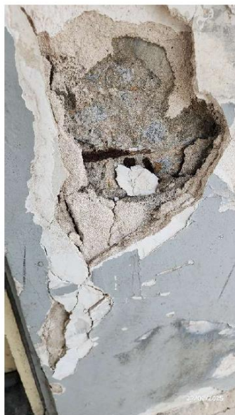
Foto 03: Detalhe do pilar com corrosão de armadura.
