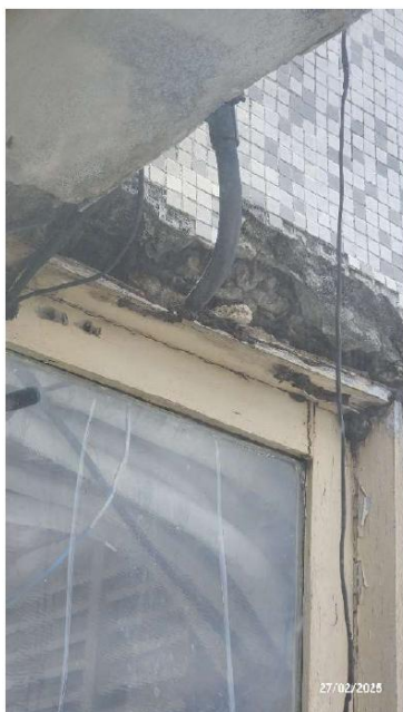
Foto 09: Viga de bordo da fachada em estado avançado de corrosão/deslocamento.
