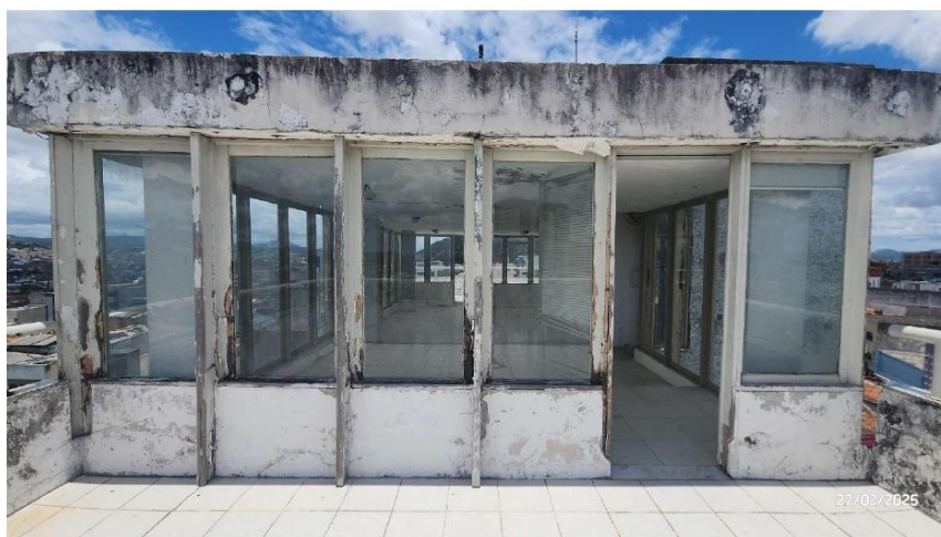
Foto 10: Trecho da coberta sinalizando necessidade de intervenção na viga de bordo.
