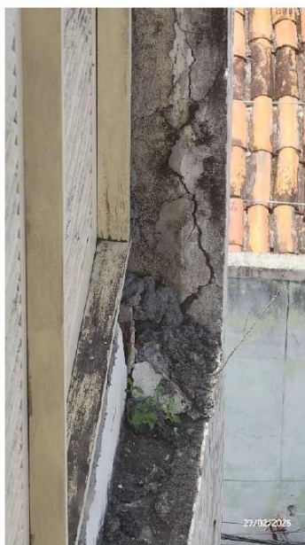
Foto 05: Trecho de pilar da fachada com fissuras e deslocamento de concreto.
