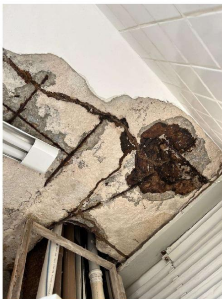
Foto 06: Laje interna bastante deteriorada.
