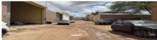
Rua Durval de Lima, Bairro Boa Vista I Solicitação do calçamento
